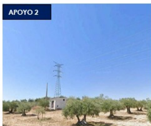
Foto realizadas "In situ". Apoyos de Línea AT132 kV
