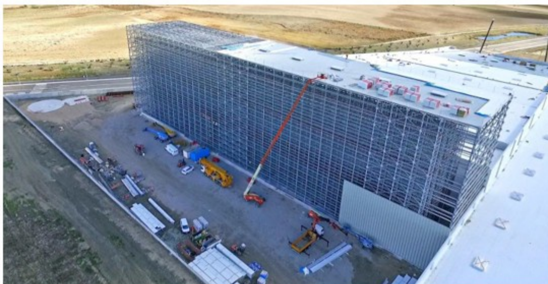
Construcción "silo" robotizado de almacenaje de la empresa Ehlis. Plataforma Central Iberum, Illescas
