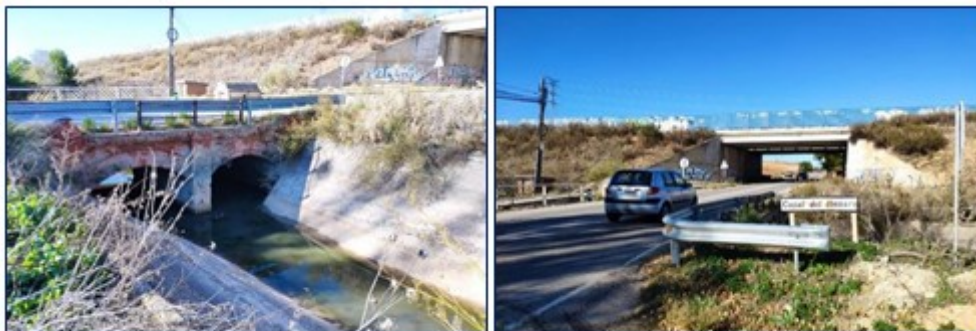
Canal del Henares a su paso por el T.M. de Villanueva de la Sagra.
