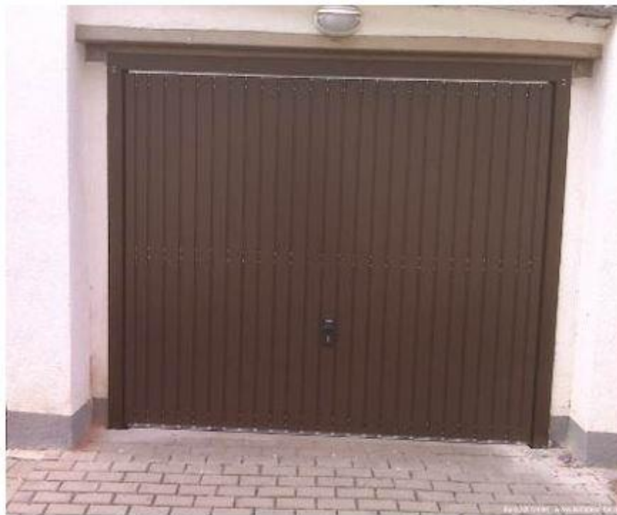
1.4. Puerta seccional (lateral), lamas verticales imitación madera
