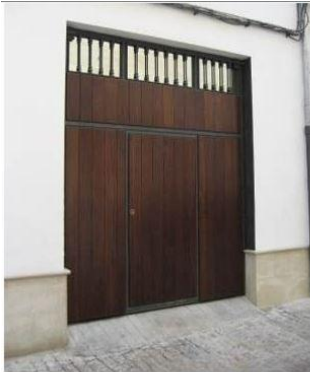
1.3. Puerta basculante de lamas metálicas verticales.
