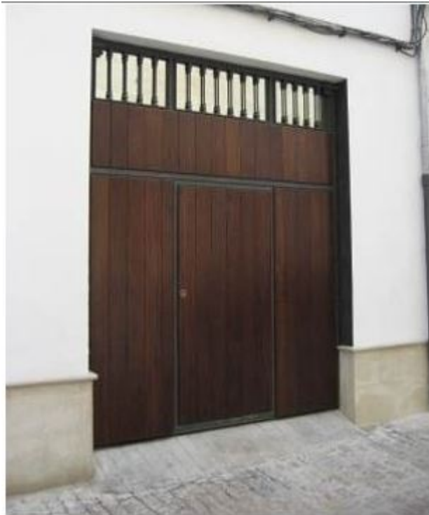
1.2. Puerta basculante, lamas de madera verticales, puerta peatonal integrada y bastidor metálico visto.
